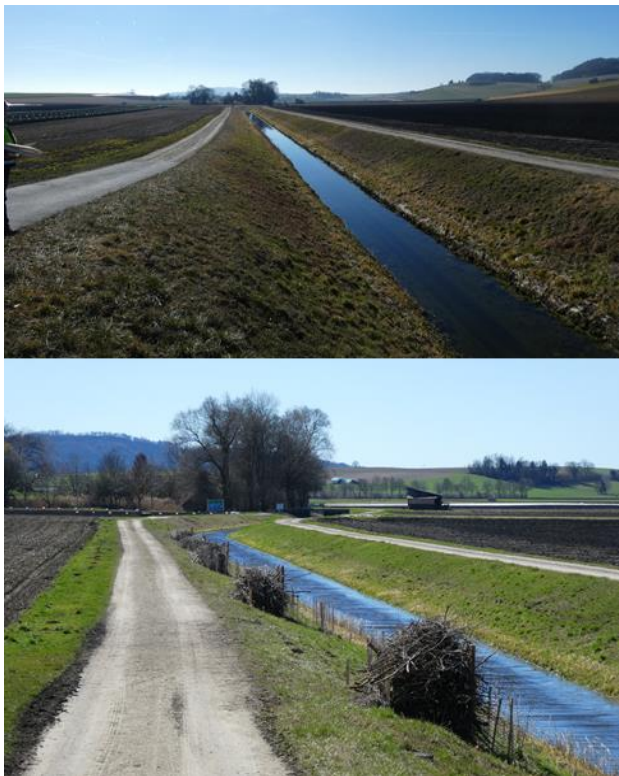
Abb. 4 | Der Stägmattenkanal vor (oben) und nach der ersten Etappe der Aufwertung (unten).
